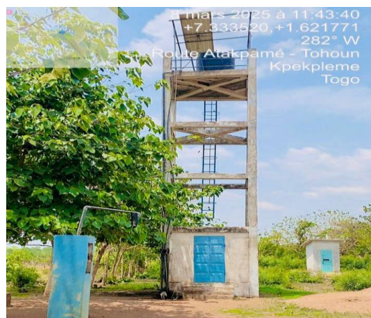
Photo 10. Forage avec BF autonome Prise de vue : Consultant, mars 2025
