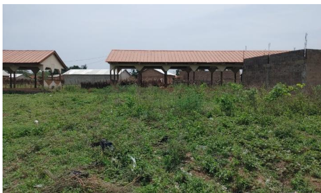
Photo 19. Hangars du nouveau marché Prise de vue : Consultant, mars 2025
