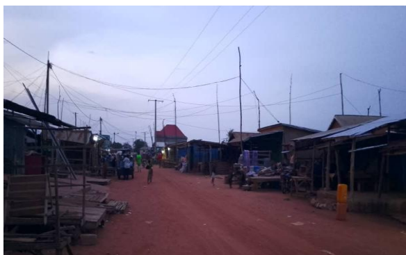
Photo 5. Vue d'ensemble de l'emprise de passage de l'adduction d'eau
