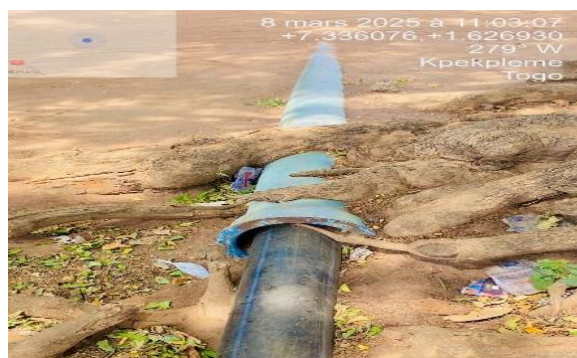
Photo 6. Vue d'un tuyau d'adduction à l'entrée du château
