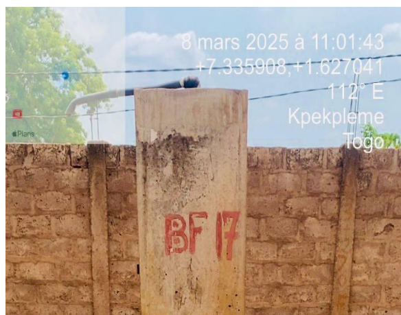
Photo 9. Vue d'une BF existante Prise de vue : Consultant, mars 2025
