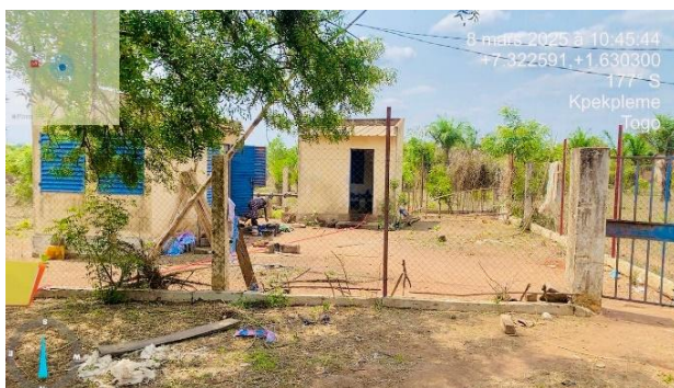
Photo 1. Site de pompage du forage N1 alimentant l'actuel réseau Prise de vue : Consultant, mars 2025
