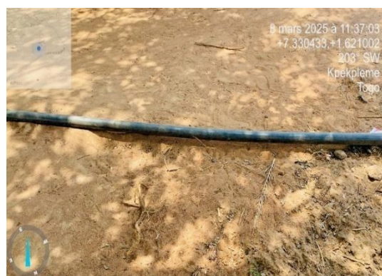
Photo 8. Vue d'un tuyau de distribution du réseau existant à Kpékplémé
