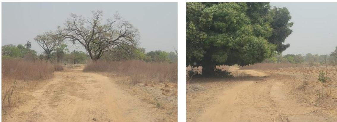
Photo 16: Etat de la piste d'accès à la localité
