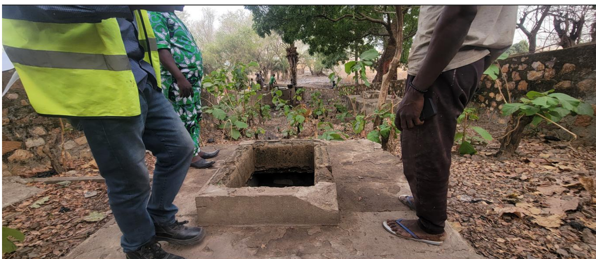
Seconde source de captage située au pied de la montagne (point d'émergence d'eau)
