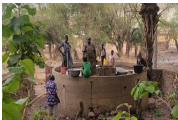
Réservoir au sol de la source de captage
