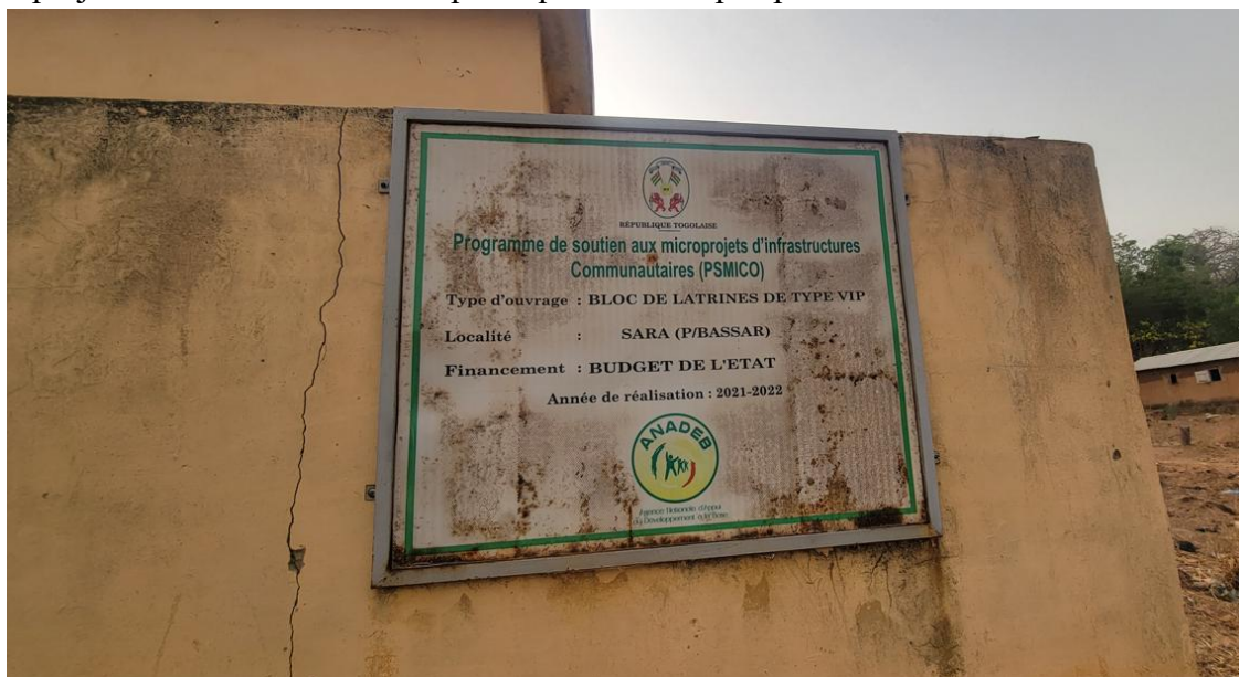
Photo 9: Latrine de type VIP réalisée par ANADEB. Prise de vue : Consultant, février 2025
