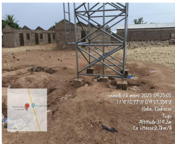
Photo 6: Vue de l'emprise de construction de la BF de Sam-Naba Centre 2
