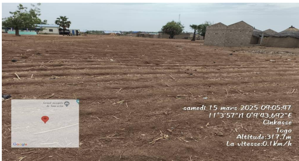
Photo 1: État initial du site de pompage Prise de vue : Consultant, Mars 2025
