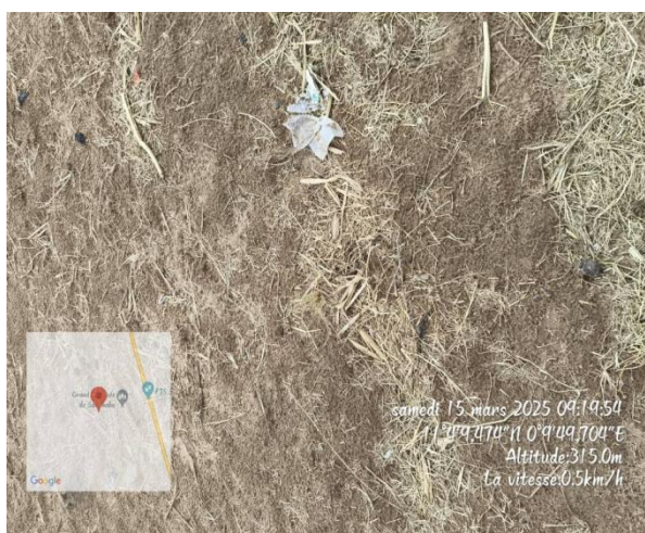
Photo 5: Vue de l'emprise de construction de la BF de Salam 2
