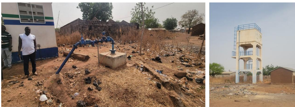
Photo 5 : le château à réhabiliter, le point de captage d'eau et le local technique abritant le groupe électrique
