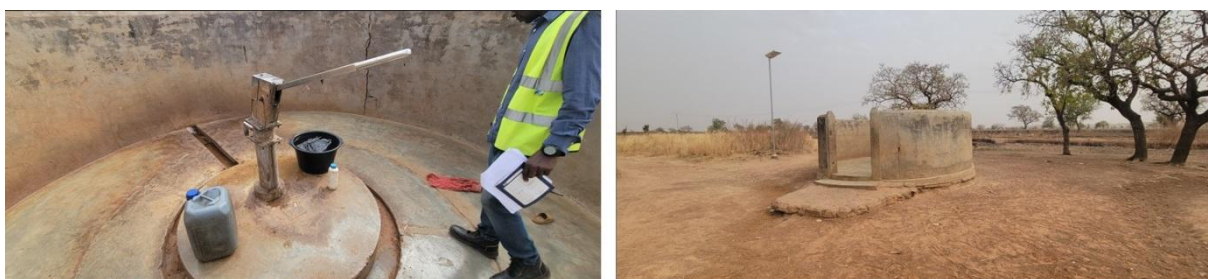
Photo 6 : La PMH de la localité de Délika à réhabiliter
