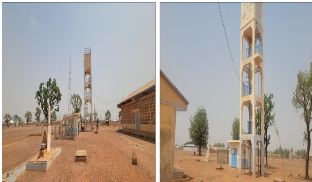
a) Le château d'eau à réhabiliter, le point de captage ainsi que le local technique abritant le groupe électrogène
