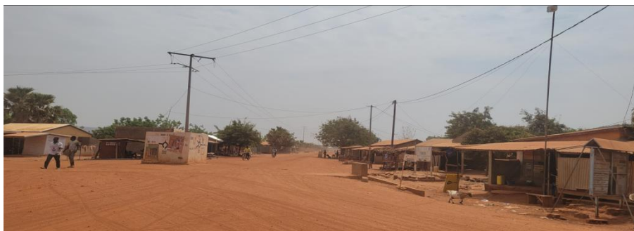
Photo 11 : Etat de la piste traversant la localité Prise de vue : Consultant, 2025.
