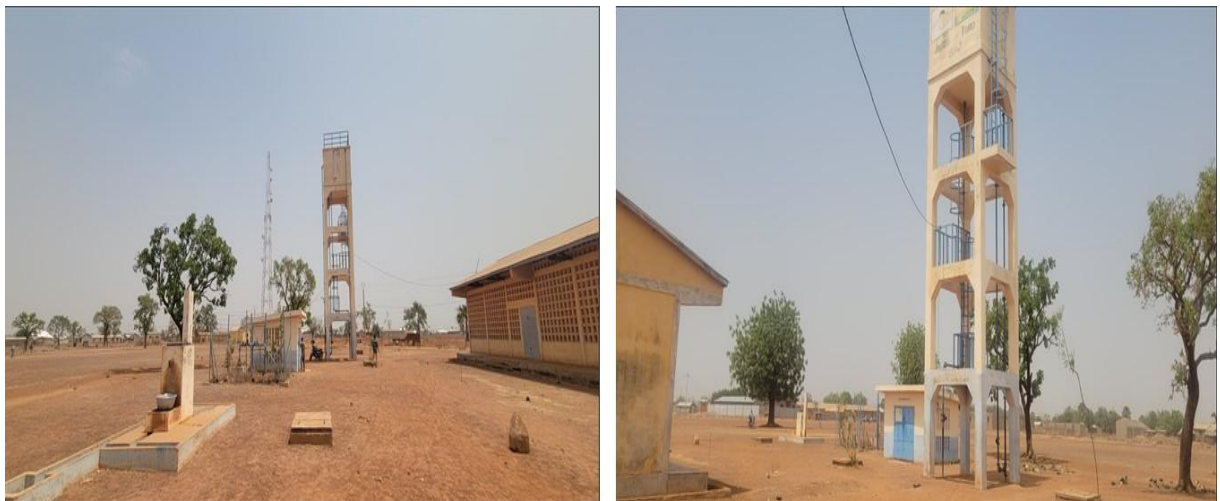
Photo 1 : Le château mini de point de captage d'eau et de local technique et du groupe électrique à réhabiliter
