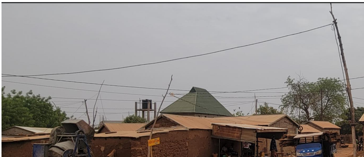
Photo 9 : Les fils électriques dans la localité Prise de vue : Consultant, 2025.
