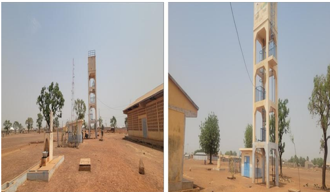
c) Le château d'eau à réhabiliter, le point de captage ainsi que le local technique abritant le groupe électrogène
