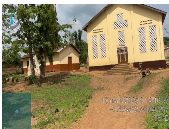
Photo 14: Église catholique de Mangoassi
