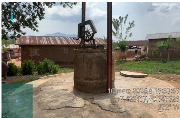
Photo 11: Vue d'ensemble d'une emprise de construction d'une Borne fontaine Prise de vue : Consultant, mars 2025
