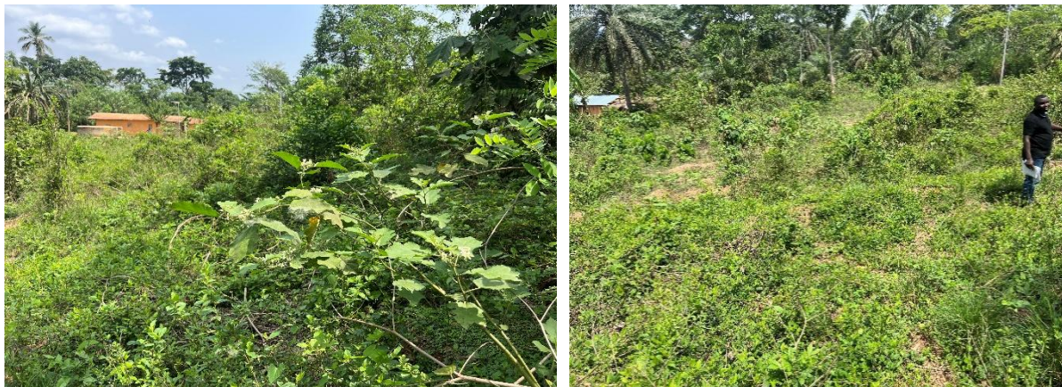
Photo 7: Vue d'ensemble du site de construction de la station de traitement de Mangoassi
