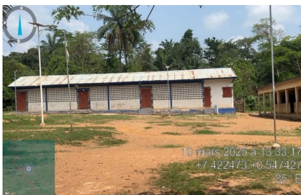
Photo 19: CEG Mangoassi Prise de vue : Consultant, mars 2025
