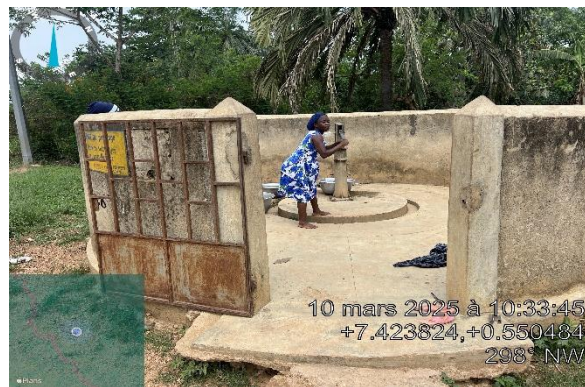
Photo 12: Vue d'ensemble d'une emprise de construction d'une Borne fontaine Prise de vue : Consultant, mars 2025
