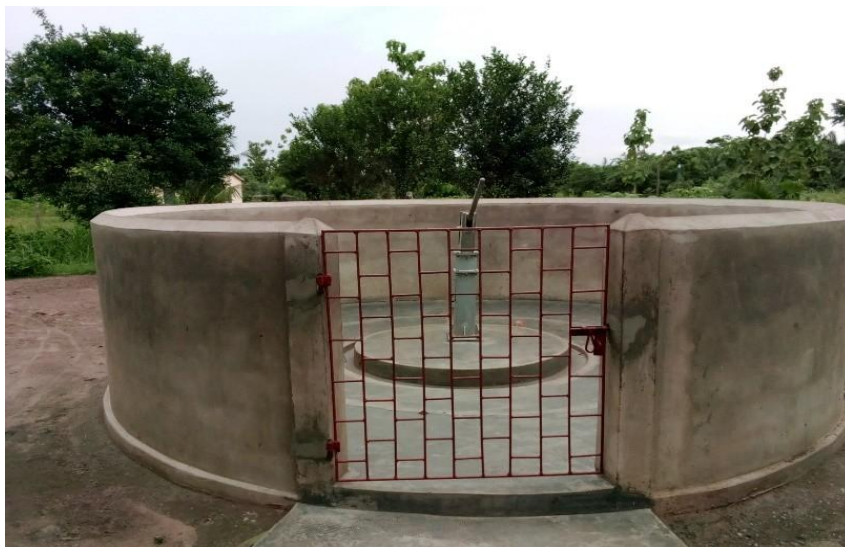
Photo 5: PMH existant utilisé à KPEVEGO (Prise de vue, Consultant, 2017)
