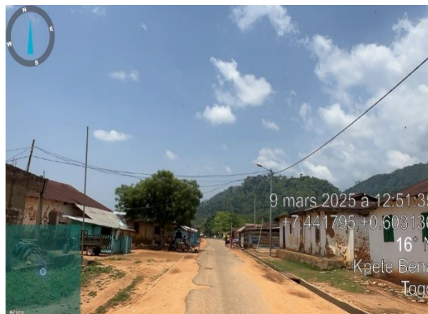
Photo 14 : Vue d'ensemble d'un passage de la conduite de distribution de l'eau à Kpete Bena Source : Consultant, mars 2025
