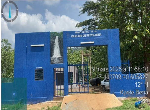
Photo 2 : Aperçu de l'entrée de la cascade pour accéder au site de pompage Prise de vue : Consultant, mars 2025
