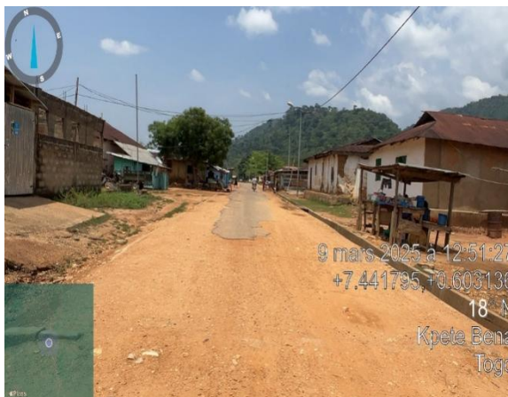
Photo 13 : Vue d'ensemble d'un passage de la conduite de distribution de l'eau à Kpete Bena Source : Consultant, mars 2025
