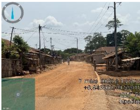
Photo 16: Vue d'ensemble d'un passage de la conduite de distribution de l'eau à Kpadapé Prise de vue : Consultant, Mars 2025
