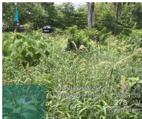
Photo 12: Vue partielle du site de traitement Prise de vue : Consultant, Mars 2025
