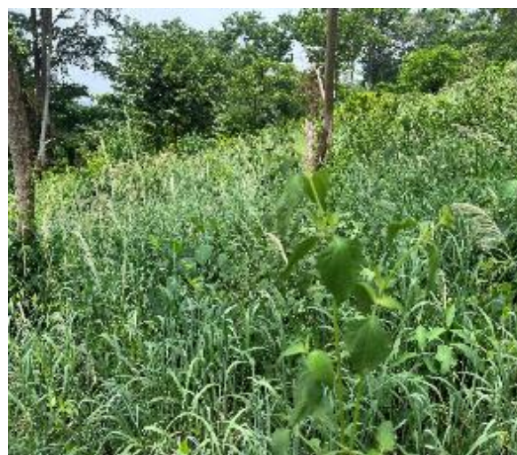
Photo 10: Vue d'ensemble du site de construction de la station de traitement Prise de vue : Consultant, Mars 2025
