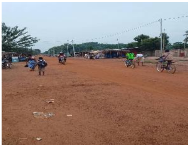
Photo 9: Vue d'ensemble d'un passage de la conduite de distribution de l'eau à Kati Prise de vue : Consultant, Mars 2025
