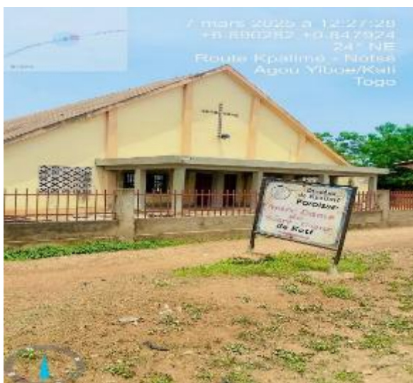
Photo 13: Église catholique de Kati Source : Consultant, Mars 2025
