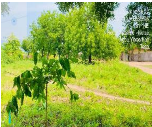
Photo 5: Vue d'ensemble du site de construction de la station de traitement Prise de vue : Consultant, Mars 2025
