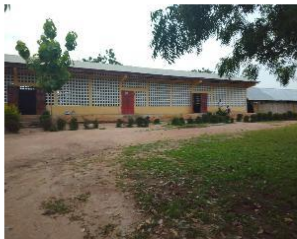
Photo 6: Lycée de Kati à côté du site de construction de la station de traitement Prise de vue : Consultant, Mars 2025
