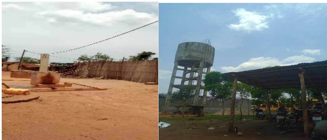
Planche 6 : BF et château d'eau dans la localité de Gakpé centre (Prise de vue, consultant, mars 2025)
