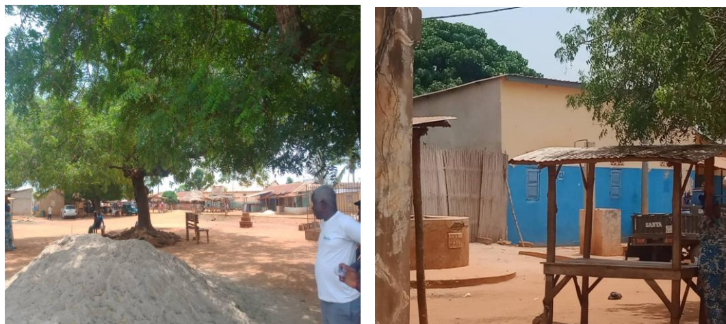
Planche 4 : Etat initial du site du château d'eau dans Atigomé (Prise de vue, Consultant, Mars 2025)
