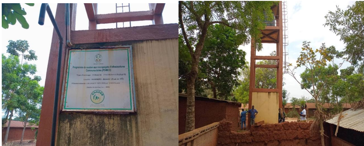
Planche 3 : Forage existant à Dzrekpo, Construit par l'ANADEB (Prise de vue, Consultant, mars 2025)
