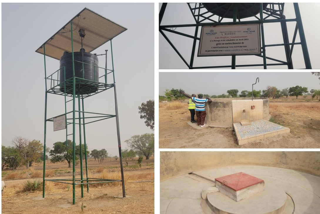
Planche 2: Site d'accueil du futur château d'eau occupé par les ouvrages d'eau déjà réalisés par l'association « eau vive pau pyrenées » au niveau du CEG BEBEDA.
