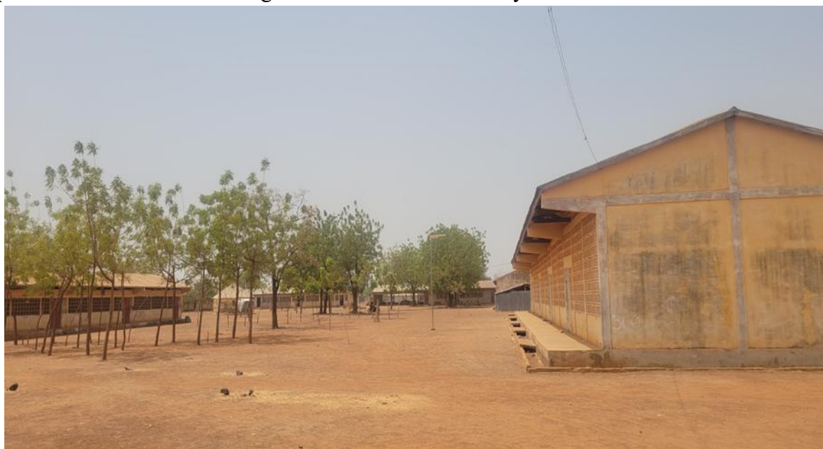
Photo 4 : Etat du site du lycée Prise de vue : Consultant, Février 2025.
