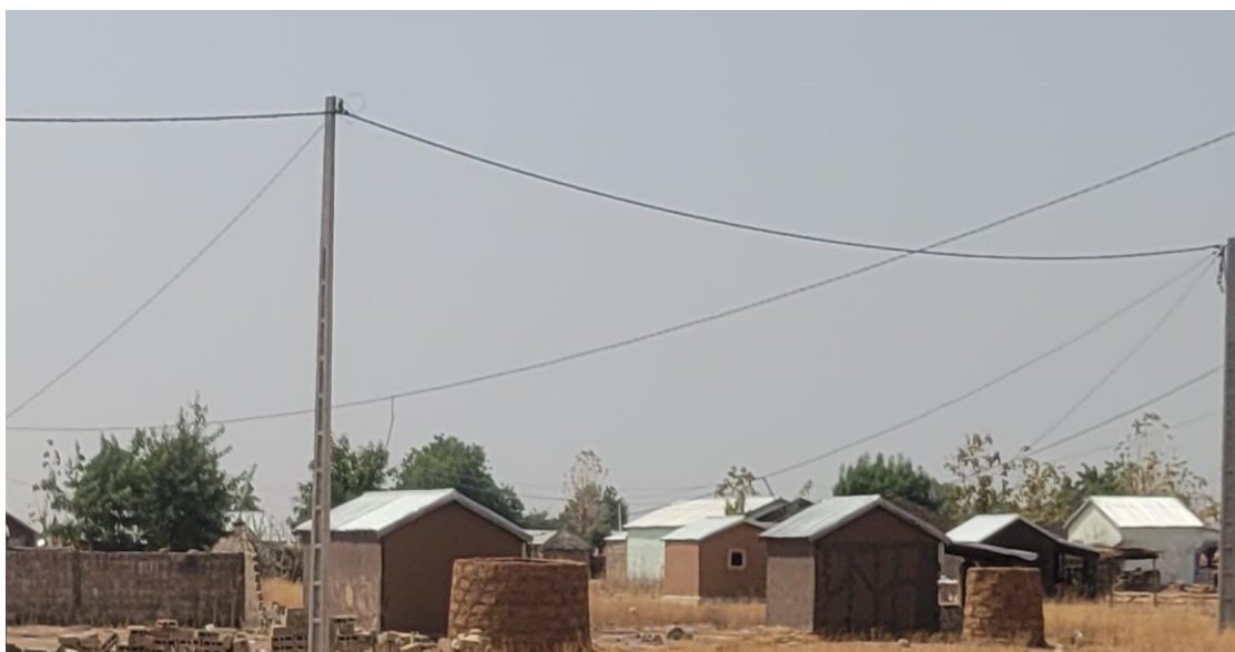
Photo 9 : Réseau de fils électrique dans la localité de Bagré, Prise de vue : Consultant, Bagré Février 2025.
