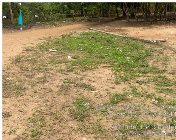
Photo 14: Vue d'ensemble d'un passage de la conduite de distribution de l'eau à Avétonou
