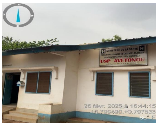
Photo 20: Vue d'ensemble de l'USP Avétonou (2)
