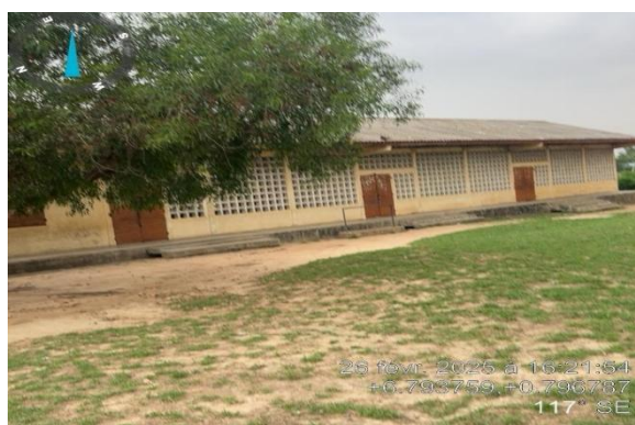
Photo 21: EPP Groupe A d'Avétonou
