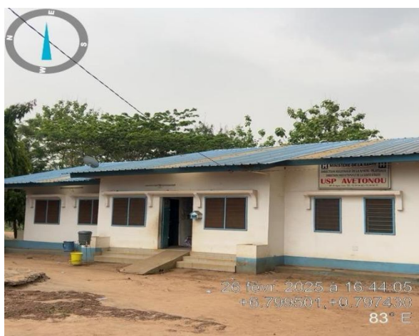
Photo 19: Vue d'ensemble de l'USP Avétonou (1)
