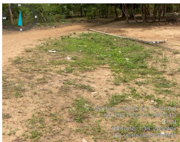
Photo 15: Vue d'ensemble d'une emprise de construction d'une Borne fontaine Prise de vue : Consultant, Mars 2025
