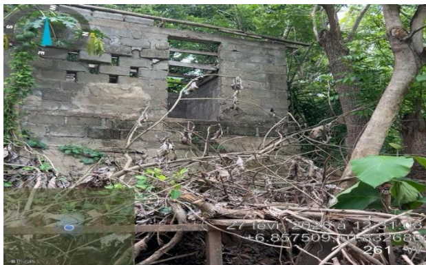
Photo 5: Ancien bâtiment délaissé sur le site de pompage
