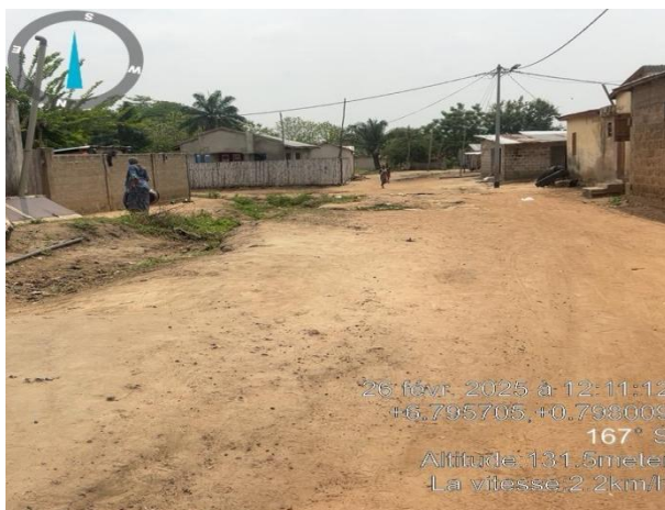
Photo 13: Vue d'ensemble d'un passage de la conduite de distribution de l'eau à Avétonou
