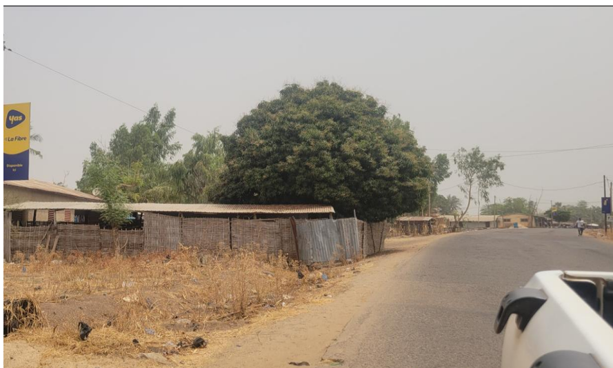
Photo 6: aspect de l’emprise de la ligne d’adduction d’eau entre le lycée et le marché. Prise de vue : : Consultant, février, 2025
