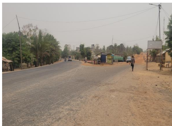
Photo 5: l'aspect de l'emprise de la ligne d'adduction d'eau au niveau du carrefour Awendjelo
