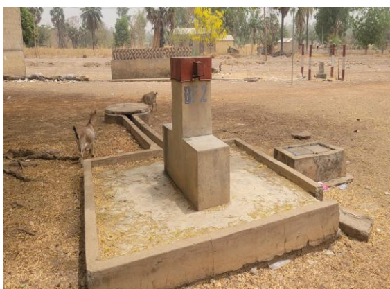
Photo 2: Forage du lycée d'Atchangbadè à équiper
