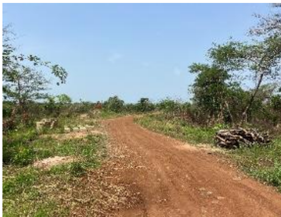
Photo 13: Vue d'ensemble d'un passage de la conduite de distribution de l'eau à Agotime Nyitoe
