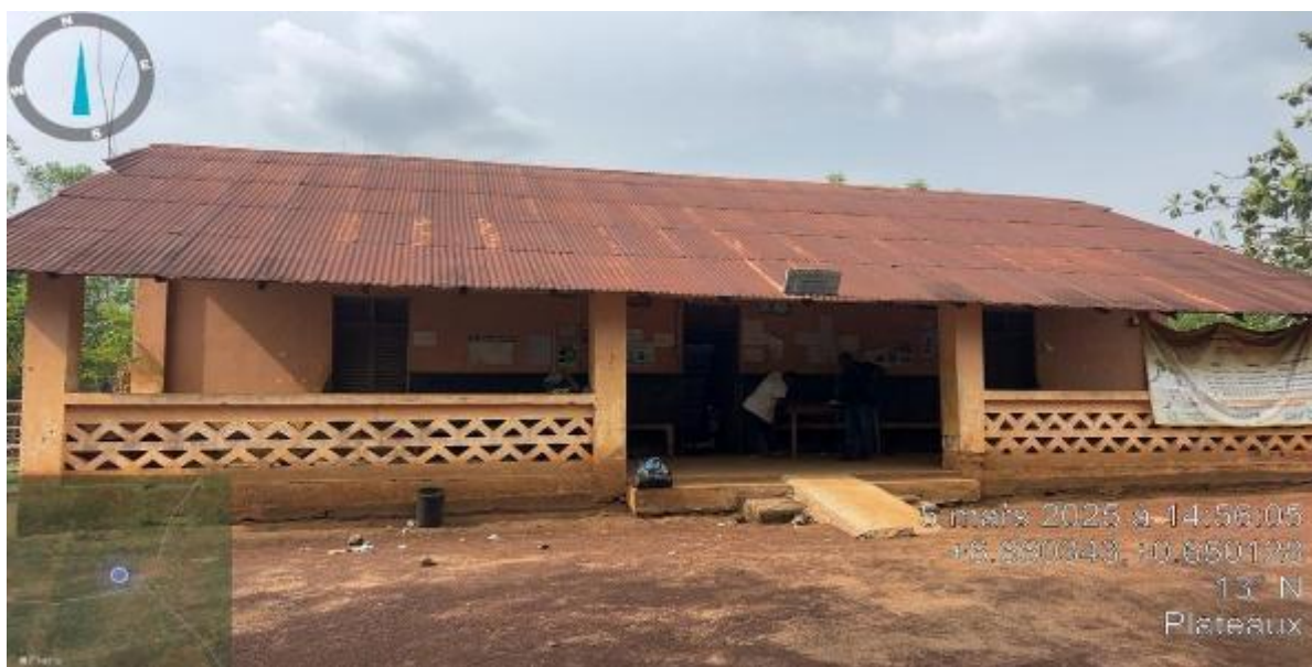
Photo 22: Unité de Soins Périphérique (USP) Nyitoe-Zukpe Prise de vue : Consultant, Mars 2025
