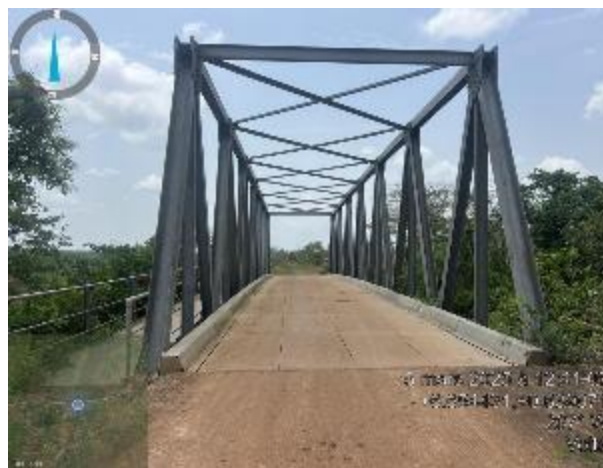
Photo 4: image du pont métallique sur la rivière Todjin Prise de vue : Consultant, Mars 2025
