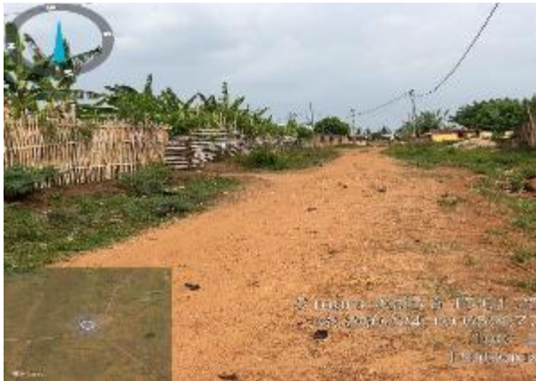
Photo 15: Vue d'ensemble d'une emprise de construction d'une Bonne fontaine Prise de vue : Consultant, Mars 2025
