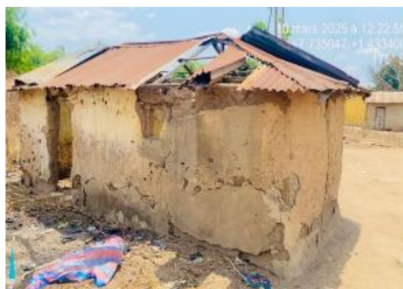
Photo 6: maison inhabitée proche du site de construction de la station de traitement Prise de vue : Consultant, Mars 2025
