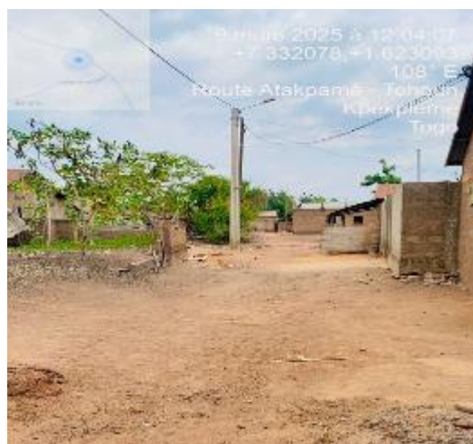
Photo 10: Vue d'ensemble d'une emprise de construction d'une Bonne fontaine Prise de vue : Consultant, Mars 2025
