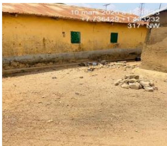
Photo 9: Vue d'ensemble d'une emprise de construction d'une Bonne fontaine Prise de vue : Consultant, Mars 2025
