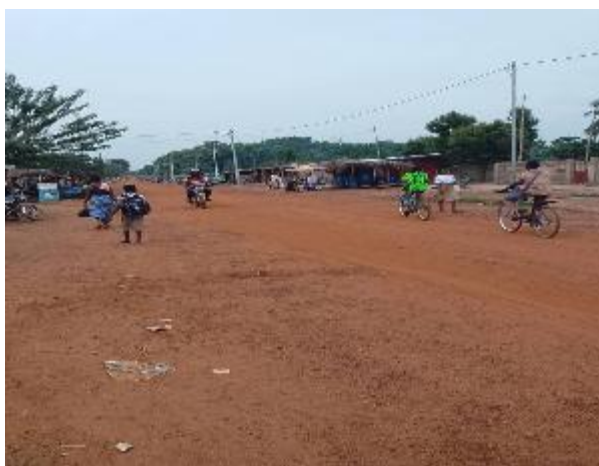
Photo 7: Vue d'ensemble d'un passage de la conduite de distribution de l'eau à Adogbénou Prise de vue : Consultant, Mars 2025
