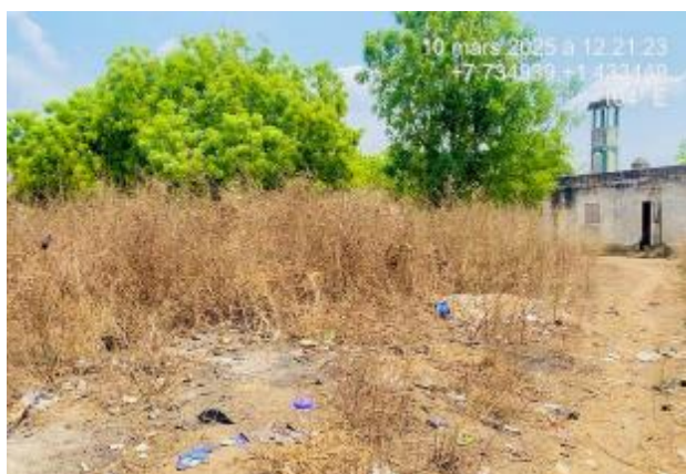
Photo 5: Vue d'ensemble du site de construction de la station de traitement Prise de vue : Consultant, Mars 2025
